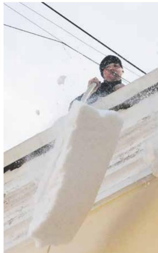
Технология работы при «полном сбросе» проста: рабочие сперва собирают снег со всей крыши у края, затем скидывают его вниз. Дворники после этого сгребают сброшенную массу с придомовой территории и грузят ее в КамАЗы. От дома на Марата, 13, например, вывезли две машины снега
